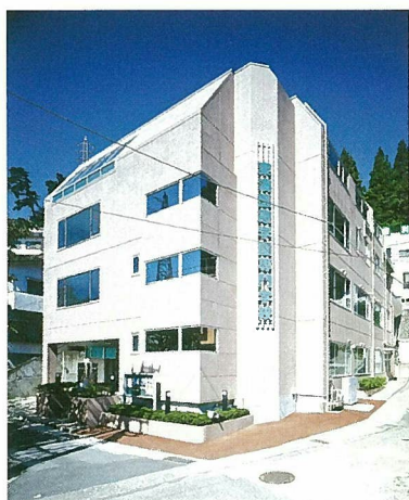
増築完成後の校舎
